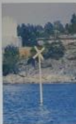
Spezialmarke i Nyssahamn. Markerar slutet på en rindledning på sjöbottnen.
